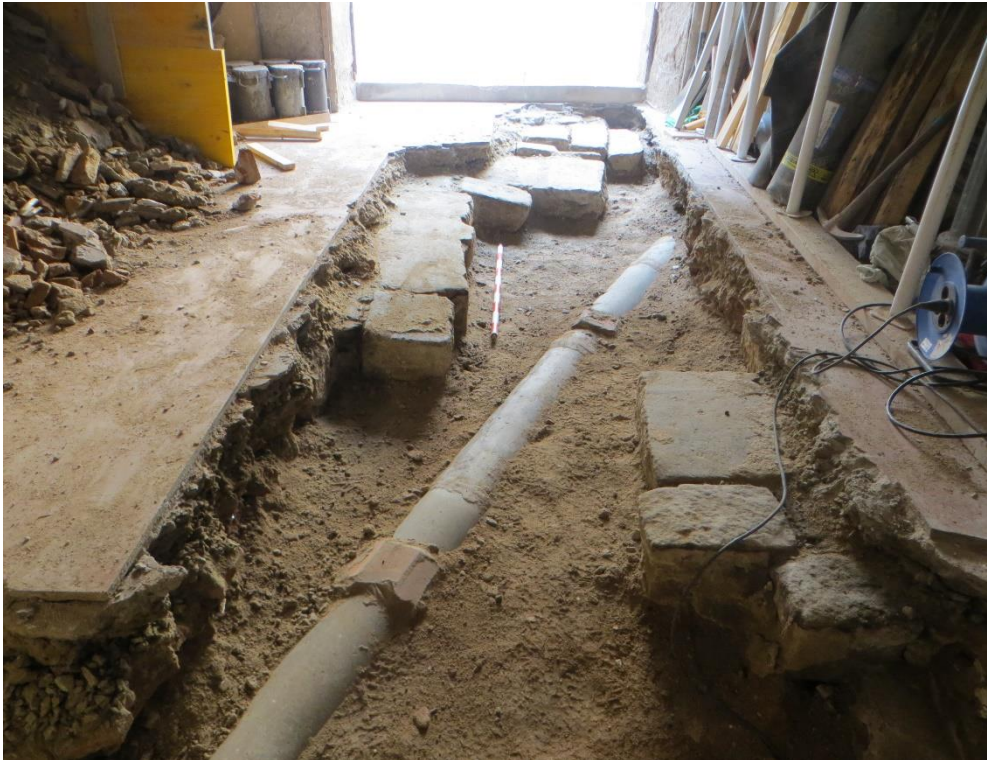
Fig. 15. Vista del tub de fibrociment U.E 18 tallant el el paviment U.E. 21
