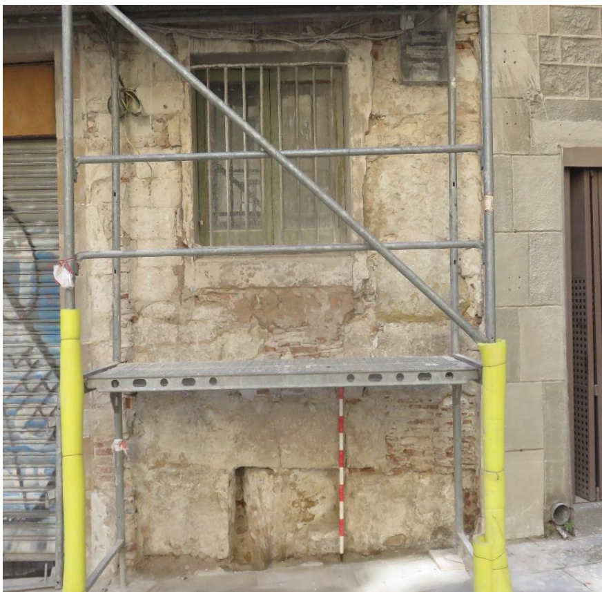
Fig 29. Tram de façana documentat. A la part inferior de la imatge, a tocar del jaló es veu el carreu col·locat a biaix.
