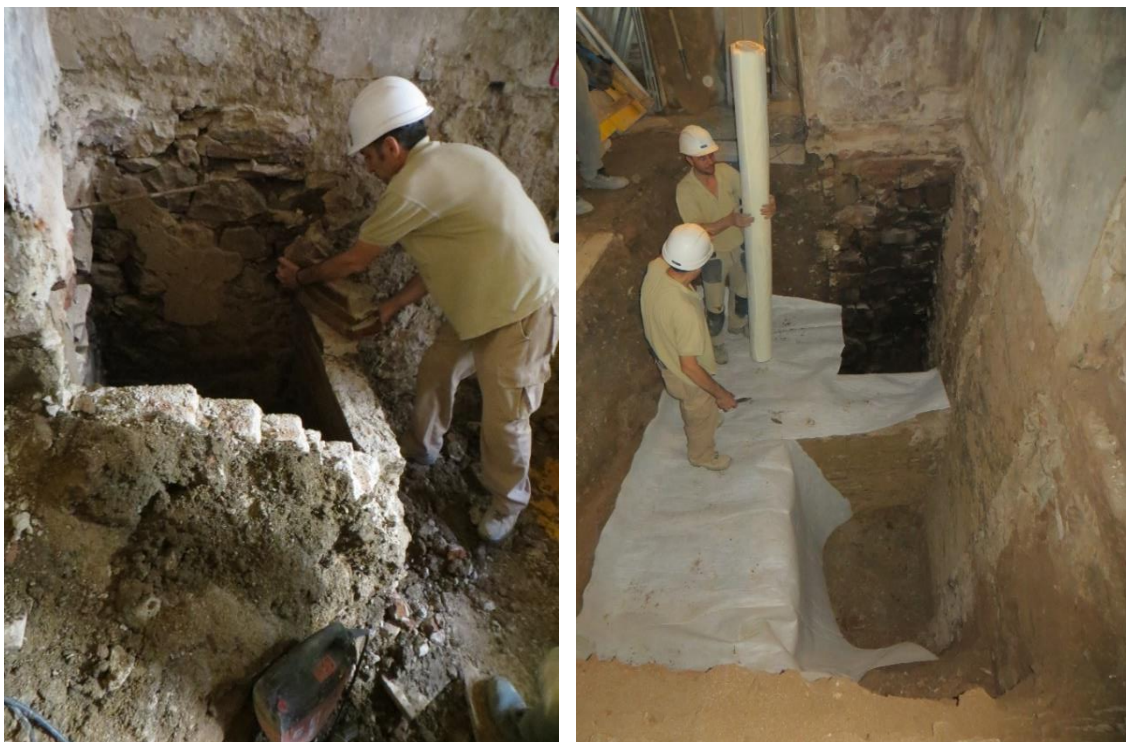
Fig. 10. Vista del desmuntatge dels pous i el seu cobriment indefinit un cop finalitzada l'excavació
