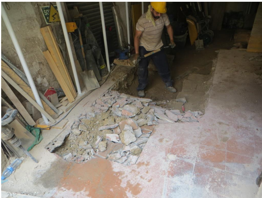
Fig.13. Detall dels treballs d'excavació del paviment de la finca.
