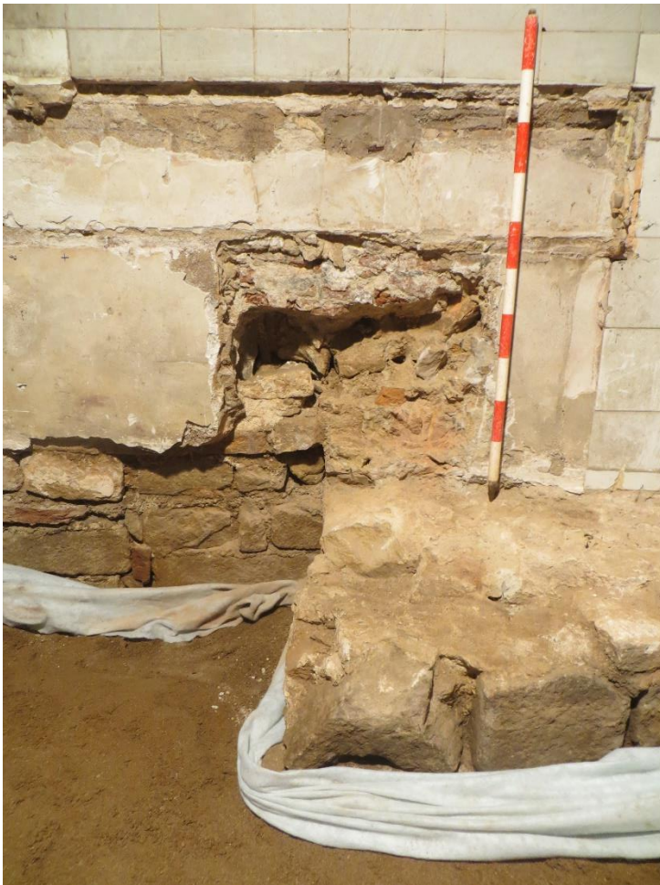
Fig 27. Detall del sondeig de paret, realitzat per sobre l'absis on s'observen els detalls delimitats en la imatge anterior.
