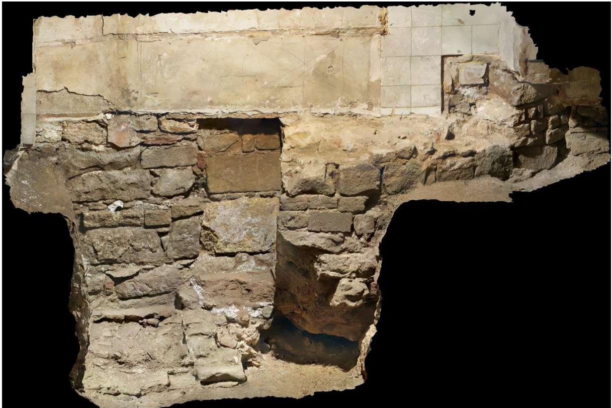
Fig 23. Vista frontal del conjunt d'estructures documentades a la banda nord del sondeig. Es veu el mur U.E 36, i la possible reforma U.E 52, també s'observa l'absis U.E 35 i l'estructura U.E 43.
