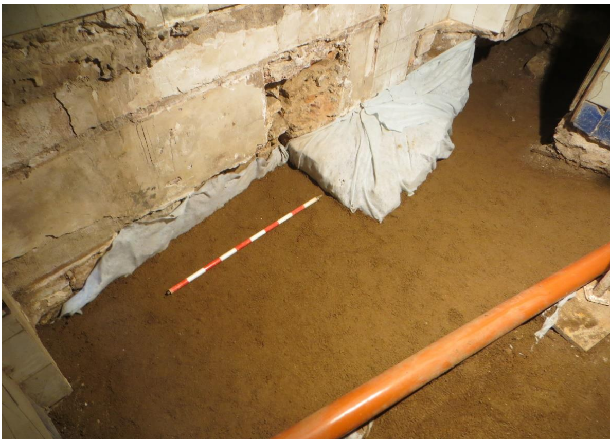
Fig 25. A la imatge superior detall del cobriment amb geotèxtil del sondeig i de l'absis, així com la protecció amb pedres de l'esvoranc en la part inferior de l'absis. A baix, vista del sondeig completament cobert amb la part de l'absis que quedarà integrada a l'obra.
