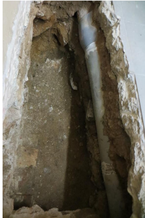
Fig 28. Vista del sondeig un cop finalitzada l'actuació.
