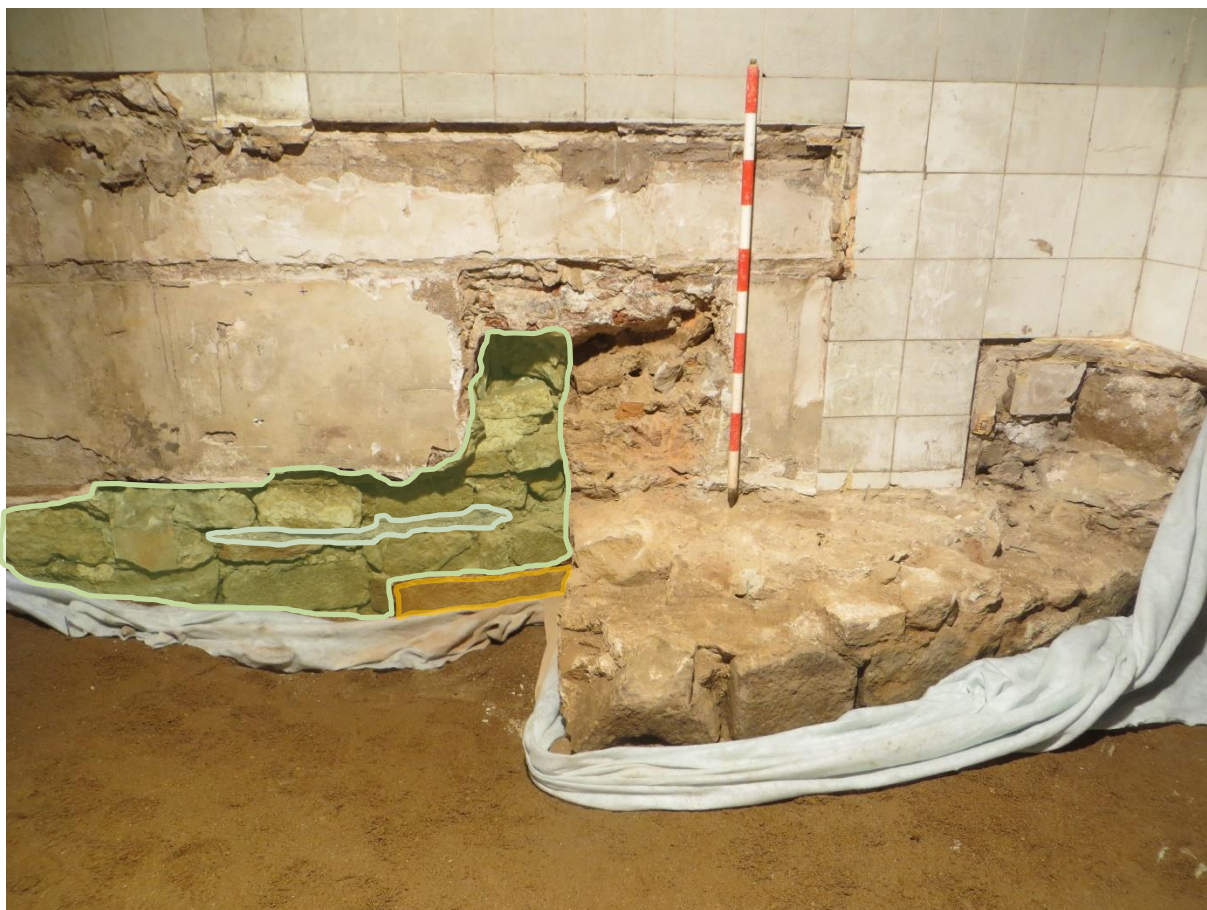
Fig 26. Vista del sondeig de paret on es veu la continuïtat del mur de façana per sobre els tres carreus. A la imatge s'ha pintat de verd el mur de façana, i de groc el lloc a partir del qual es documenten els tres carreus. També s'ha remarcat en gris, el punt on es veu la continuïtat del morter, que confirma que per sobre els carreus s'estenia la paret perimetral de la finca.
