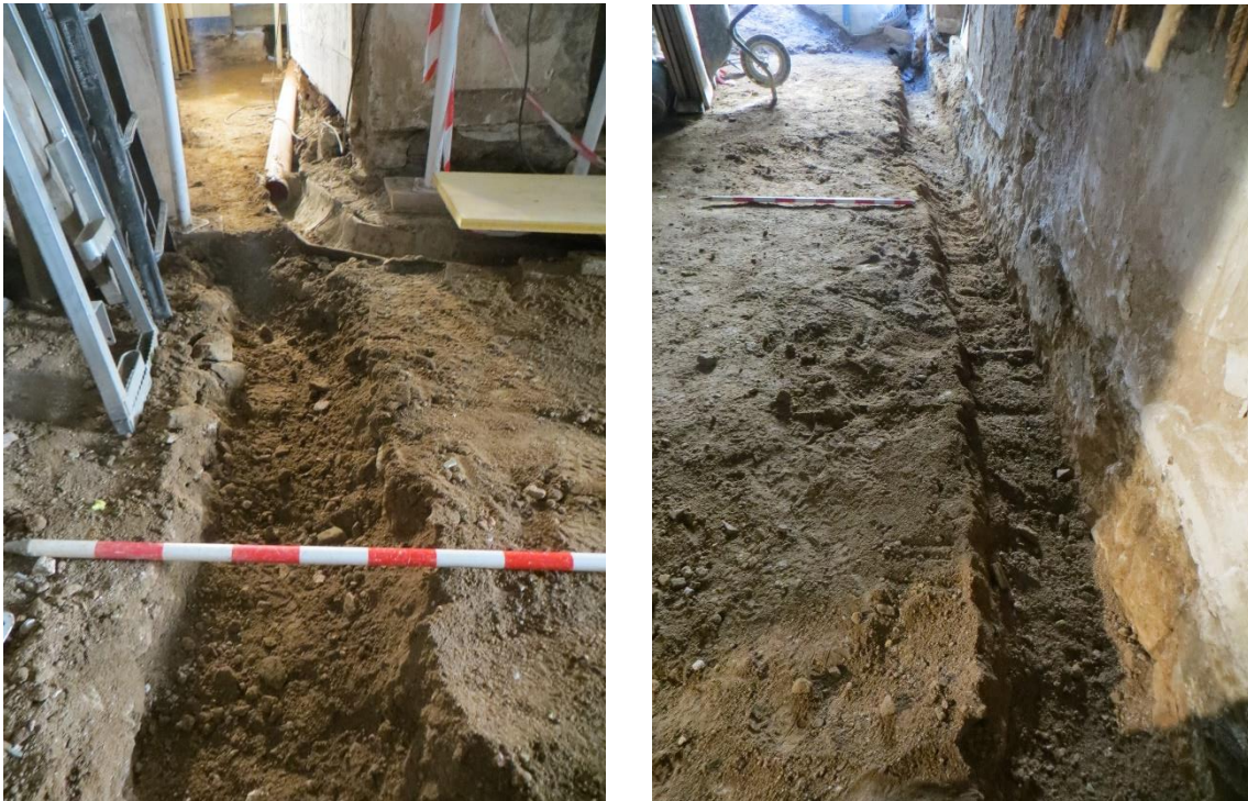
Fig.19. Vista de la rasa excavada en el vestíbul de la finca.
