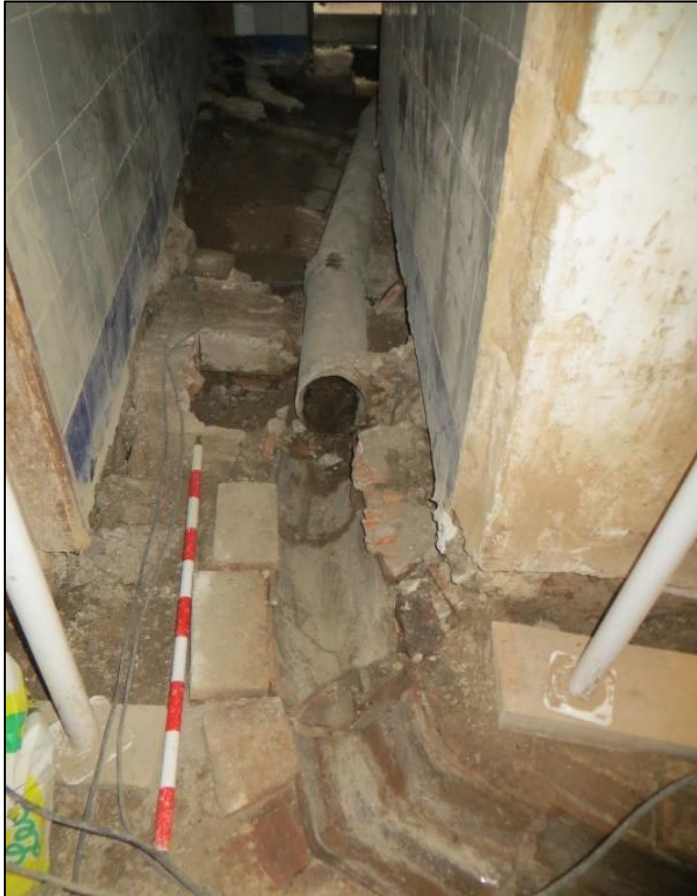
Fig.17 Vista general del corredor, on es veu el punt on la canal U.E 26 fa el gir direcció NW. En primer terme s'observa el tram amb base feta de teula corba vidrada. També es pot observar com just al final del tram del tub d'uralita U.E 29 es veuen les restes de l'estructures U.E 31
