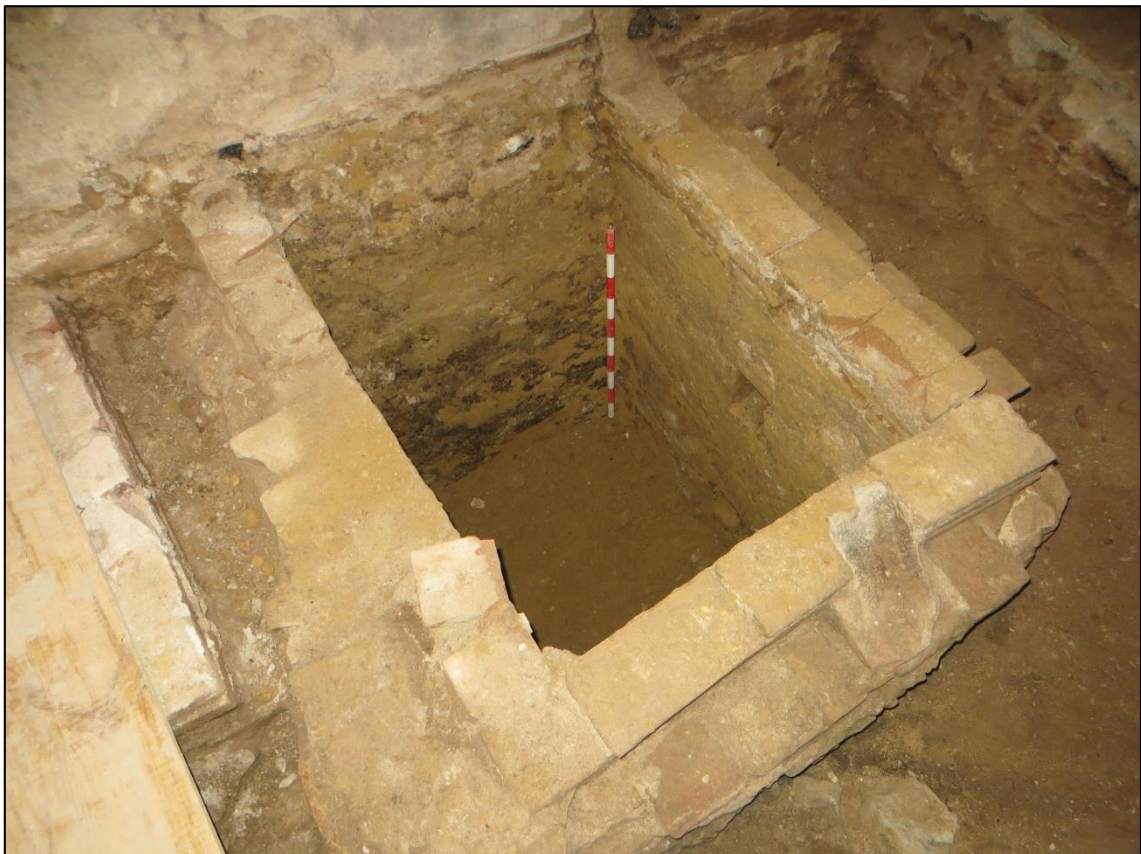
Fig 9. Vista general la fossa sèptica o pou mort un cop excavada. A la dreta de la imatge es veuen els encaixos de l'escala de paret d'accés
