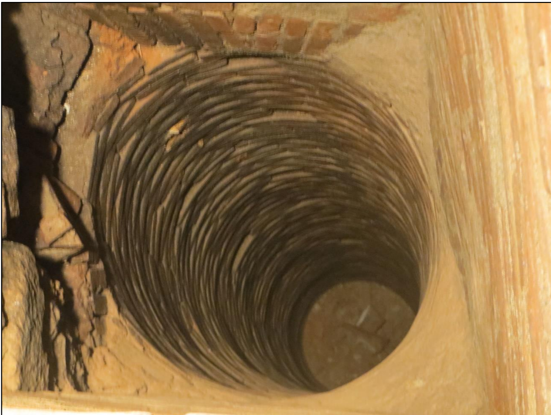
Fig 7: Detall del tram inferior del pou, on es veu tant el tram circular amb el revestiment de llosetes, com la continuació de l'estructura amb planta quadrangular.
