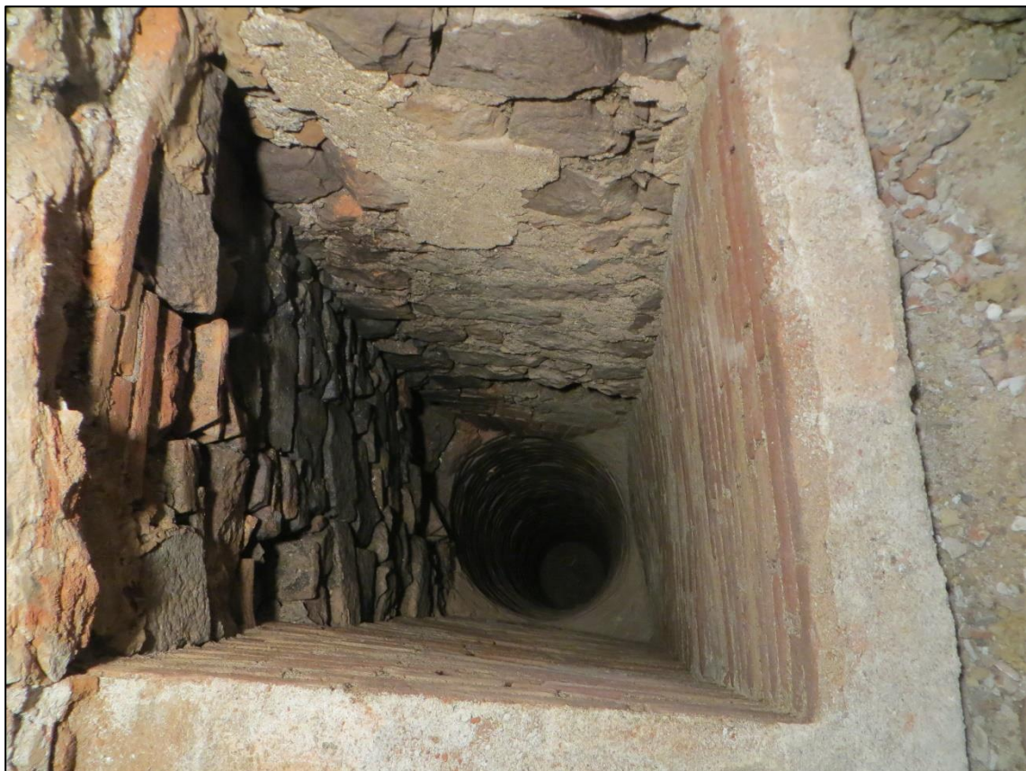
Fig 6: Vista del pou sud on es veuen les dues tècniques constructives documentades.
