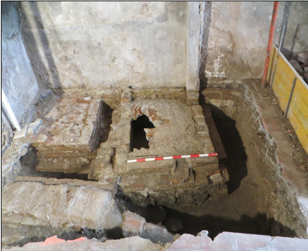
Fig. 5 Vista general del conjunt d'estructures documentades a la zona del fossat de l'ascensor. A la imatge també es poden veure les voltes U.E 06 i U.E 12 que les cobrien.
