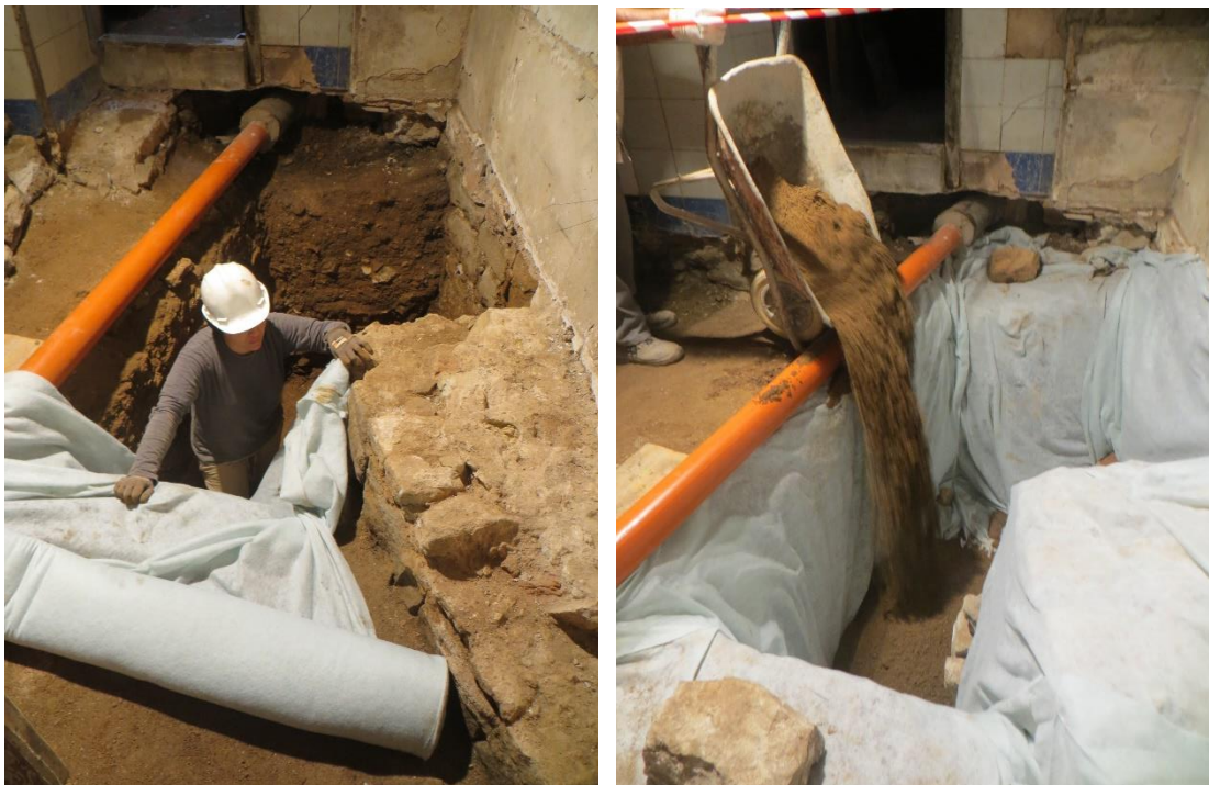
Fig 24. Detall de les tasques de cobriment indefinit de l'absis i del sondeig.
