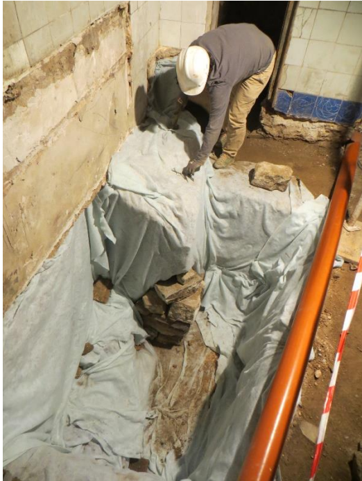
Fig 25. A la imatge superior detall del cobriment amb geotèxtil del sondeig i de l'absis, així com la protecció amb pedres de l'esvoranc en la part inferior de l'absis. A baix, vista del sondeig completament cobert amb la part de l'absis que quedarà integrada a l'obra.
